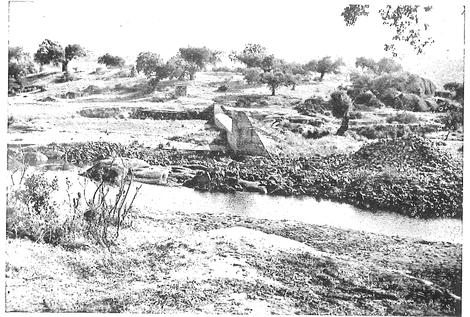
Fig. 1.—Presa vertedero para aforos en el río Aljucén, en el paraje inmediato al Molino del Boquerón, construida en terreno granítico. Durante una crecida del río, saltaron las aguas por encima del estribo derecho, quedando la obra inutilizada por variar el cauce de las aguas, como se aprecia en la foto.
